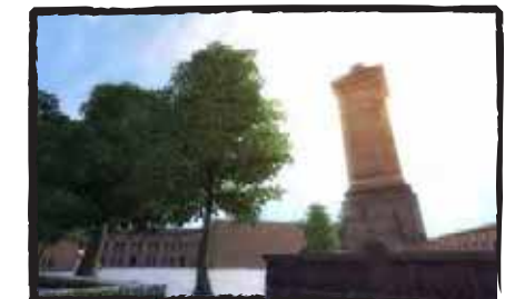
Schwachpunkt Wasserversorgung: es gab nur diesen einen Brunnen im Festungsinnen
